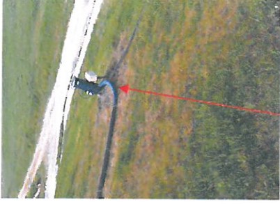
Illustration N14 Point bas sur flexibles 110 des puits N° 314; 317; 1009; 877; 759; 884; 648;
