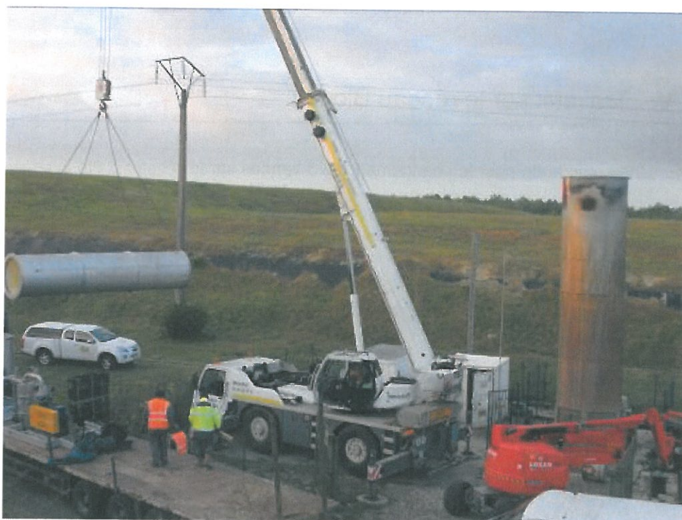
Figure 15 : Déchargement du nouveau fût de la nouvelle torchère
