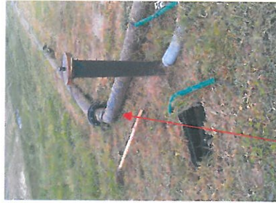
Illustration N16 Point bas sur collecteur 200 a proximité du puits 761 ce qui génère une importante variation de la dépression
